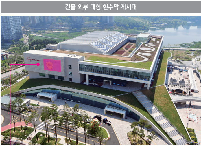
건물 외부 대형 현수막 게시대 • 규격 사이즈 : 14.2m x 8m • 시공방법 : 사방줄미싱
